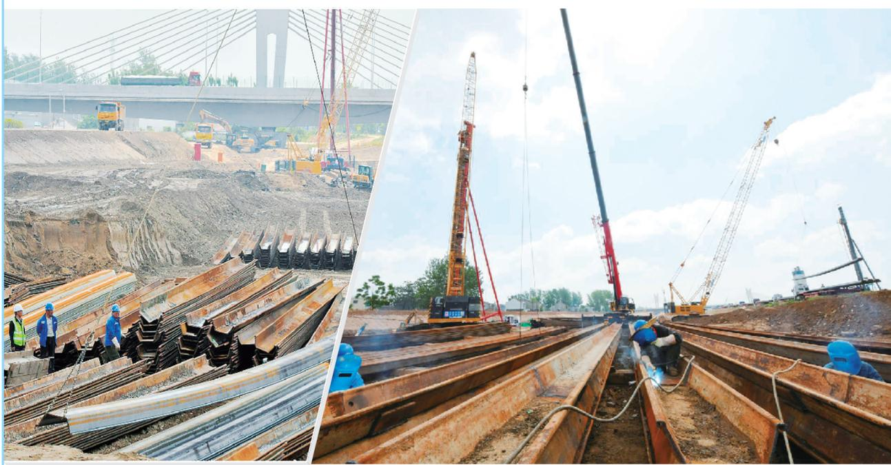
5月9日上午,工人们正在沙颍河周口至省界航道提升工程(船闸及桥梁工程)郑埠口一线船闸改扩建项目工地进行围堰施工,为后续船闸主体施工奠定基础。郑埠口一线船闸改扩建工程项目设计为II级船闸,设计船型为2000吨级货船及110TEU集装箱船,建设规模为280米×34米×5.6米(长×宽×门槛水深),主要建筑物包括新建船闸主体及配套附属工程等。
